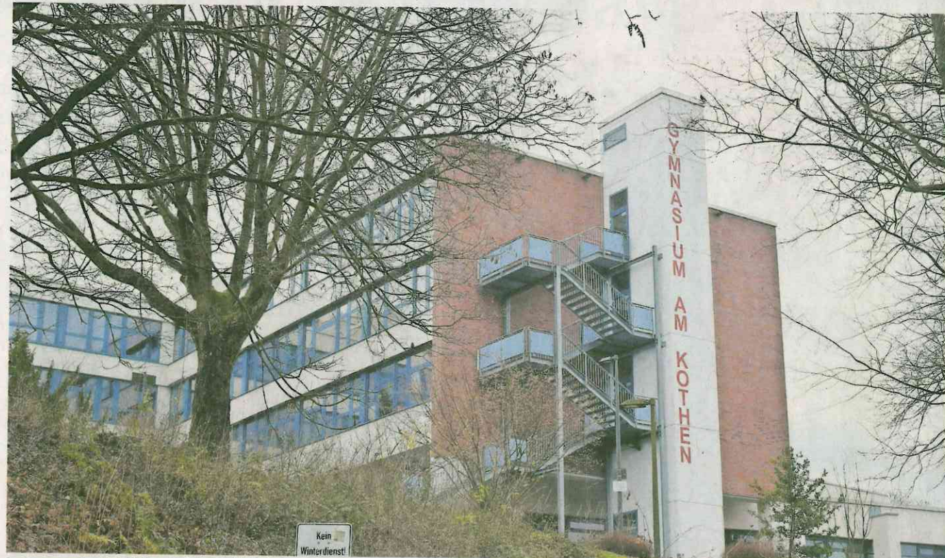
Im kommenden Schuljahr wird der Ostflügel saniert, anschließend folgt der Nordflügel.
